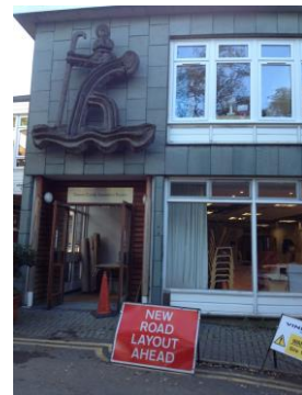
Das St. Christopher's Hospice in London wird modernisiert und richtet sich neu aus (2013)
