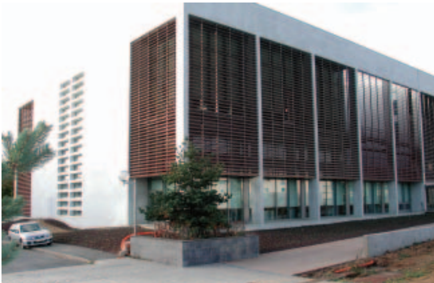
Façade principale et façade sud-est
