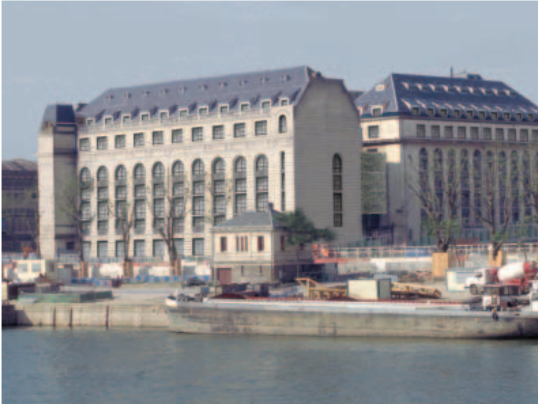
Bibliothèque de l'Université Paris 7 - Denis Diderot vue quai Panhard Levassor
