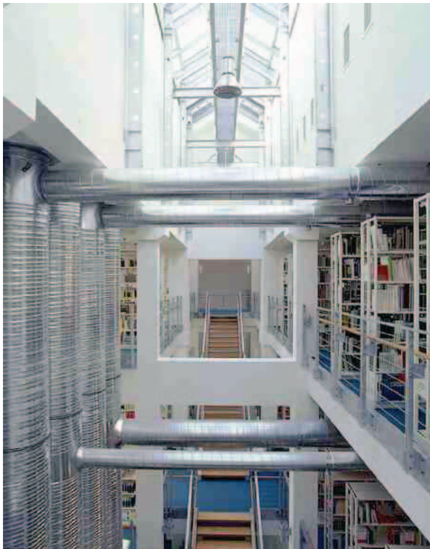
Fachhochschule Erfurt, Hochschulbibliothek, Oberlicht mit Treppe
