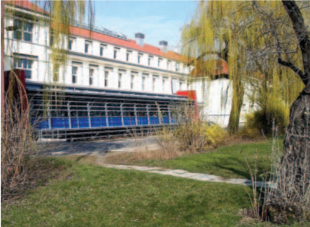
Fachhochschule Erfurt, Hochschulbibliothek, Hofansicht (Südseite)
