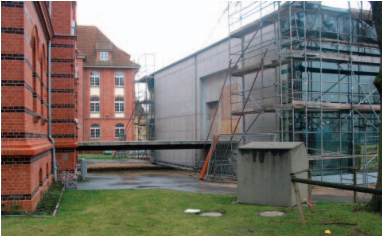
Landesbibliothek Mecklenburg-Vorpommern Blick auf die entstehende Verbindung (verglaster Durchgang) zwischen Alt- und Neubau
