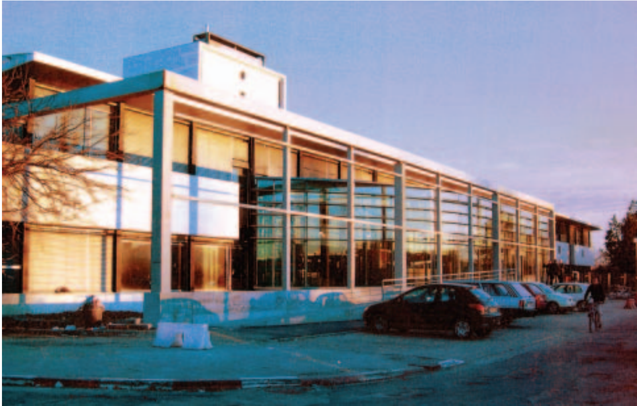
Bibliothèque Universitaire des Sciences et Techniques, Talence – Vue extérieure
