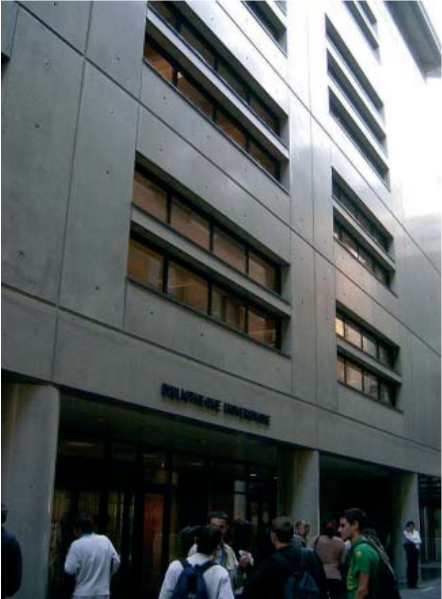
Bibliothèque de la Manufacture, Lyon, Entrée nord
