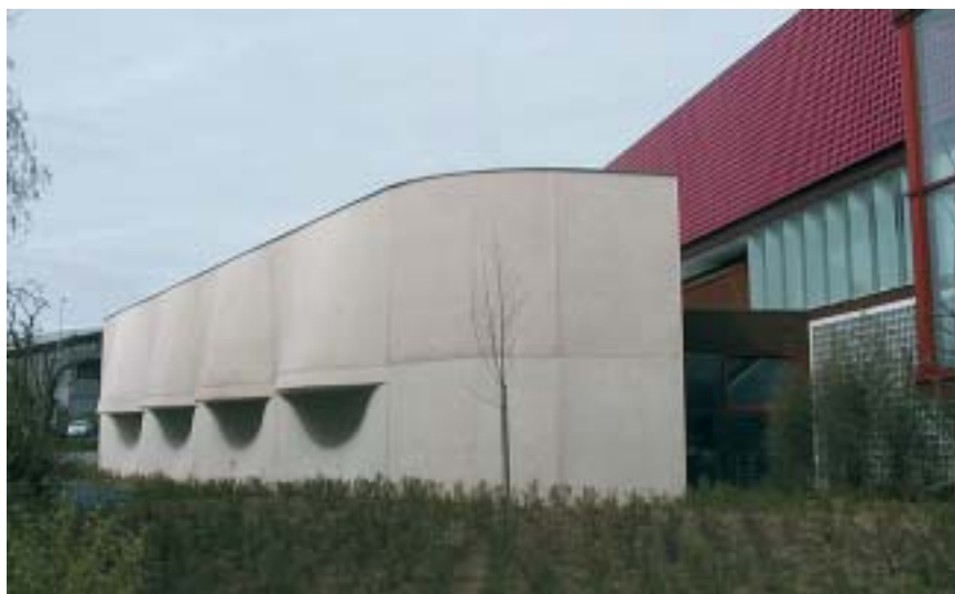
SCD de l'Université du Maine, Façade sud
