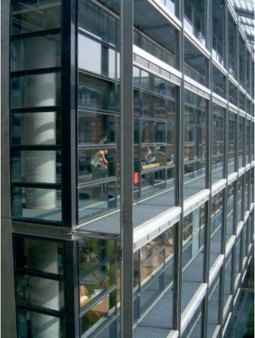
Bibliothèque de la Manufacture, Lyon, Façade vitrée sud, aile neuve
