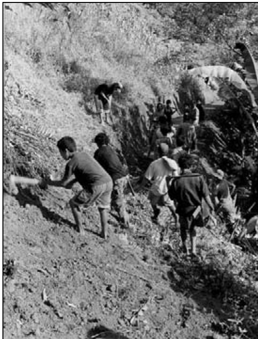
Abb. 8 Ausbaurbeiten am Fuß- und Pferdepfad nach Lawe (Quelle: Eigene Aufnahme, 2001)
