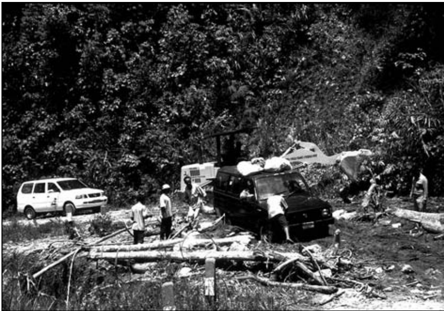
Abb. 7 Reparaturarbeiten an der Verbindungsstrasse zwischen Palu- und Kulawi-Tal nach einem Erdbeben (Quelle: Eigene Aufnahme, 2000)
