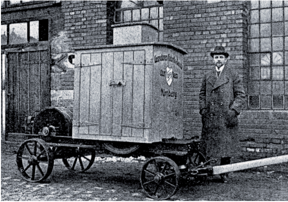
Abbildung 43: Geschlossene Anrückmaschine (Gasmotorenfabrik Köln-Deutz) mit dem Konstrukteur Oberingenieur Brennecke. 797
