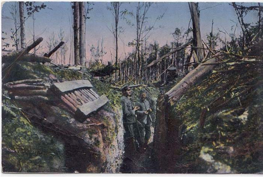
Abbildung 38: Nach einem Angriff zerstörter deutscher Schützengraben. Beim Wiederaufbau dieses Grabens wurde ähnlich viel Holz verbraucht wie bei der Neuerrichtung. 652
