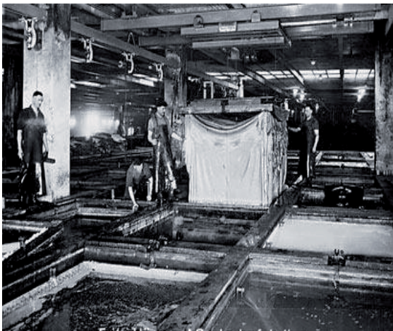
Abbildung 9: Gerbfabrik, die noch mit dem traditionellen Gerbgrubenverfahren Leder herstellte. Die Beschickung der Gruben erfolgte hier aber schon per Laufkatze. 134
