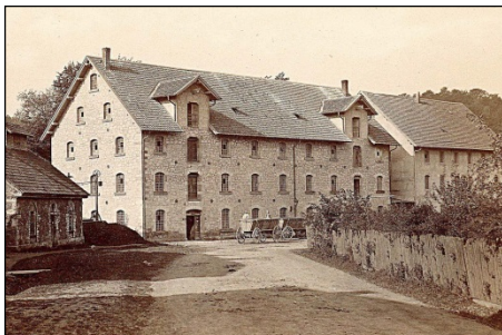
Abb. 6: Die Industriemühle mit Speicher am 2. Gefälle (Quelle: Archiv-Foto von 1888)
