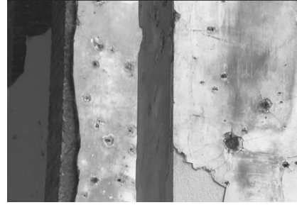
Abb. 14 (01:32): Einschüsse in einer Wand nach Sanierung
