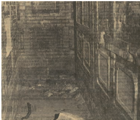
Abb 5: Einsicht in die eingetiefte Gruft der Familie des Friedhofstifters Vollmer, hier waren die Bestattungen in die Seitenwände eingeschoben. (Foto: Reinicke, Göttinger Tageblatt 1963)
