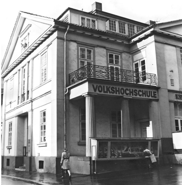
51. Hospitalstraße 1, Gebäude der Volkshochschule 1952–1957. Foto: Reinhard Lindert, VHS-Archiv
