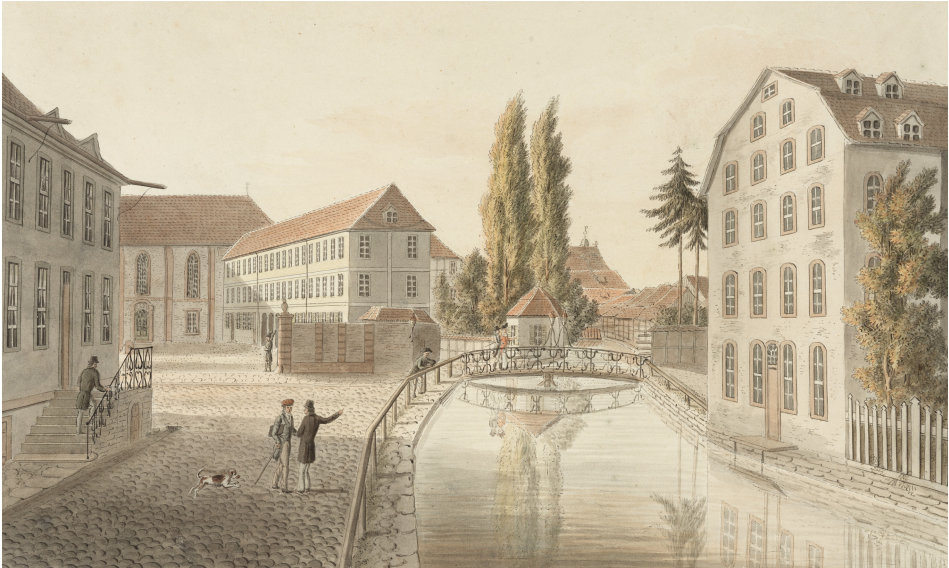
Abb. 4: Das Academische Museum war ab 1793 in dem langgestreckten Gebäude (Bildmitte) untergebracht.
