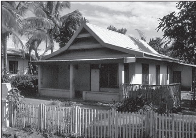
Abbildung 4: Ziegelhaus von 1987 (66 m 2 ). Das gewinkelte Dach nach buginesischem Vorbild und der dreigestufige Giebel sind die einzigen Elemente, die von der früheren Architektur übernommen wurden. (Foto: Martin Rössler 1989)
