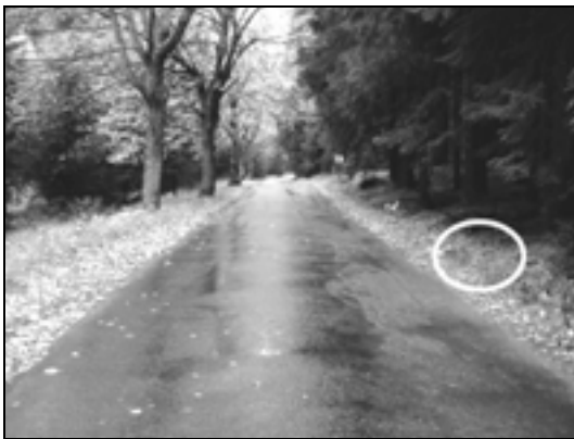
Abb. 6: Standort Brockenstraße, das Fahrzeugzählgerät ist am Straßenrand auf der rechten Seite eingebaut Foto: Wendt
