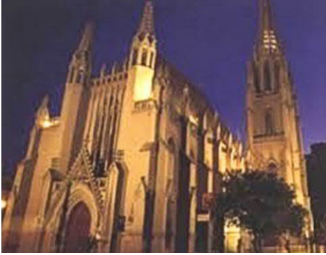
Abb. 33: Himmelfahrtskirche in Novo Hamburgo (RS). Sie wurde zwischen 1948 bis 1951 errichtet und am 7.10.1951 eingeweiht. 2.000 Menschen beteiligten sich bei der Feier. Quelle: Comunidade Evangélica de Confissão Luterana Ascensão.
